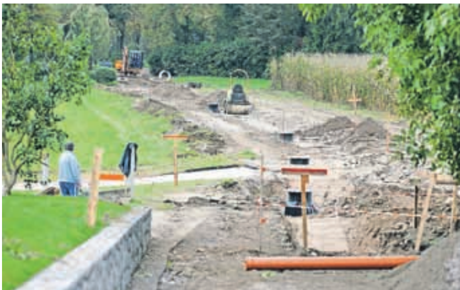
Ob gradnji kanalizacije še druga vzporedna dela /Foto: Tina Dokl
