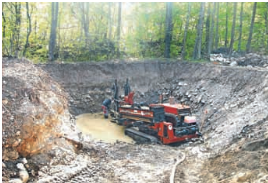
Pri gradnji kanalizacije zahteven podboj pod reko Kokro
