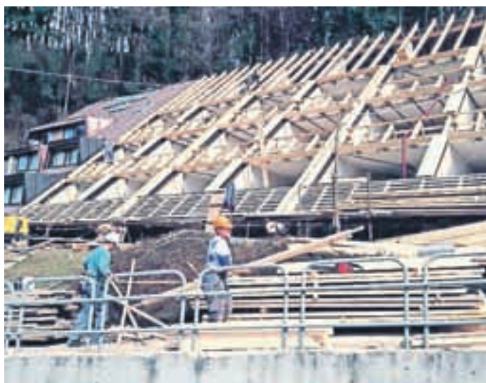
Dom starejših občanov Preddvor med obnovo
